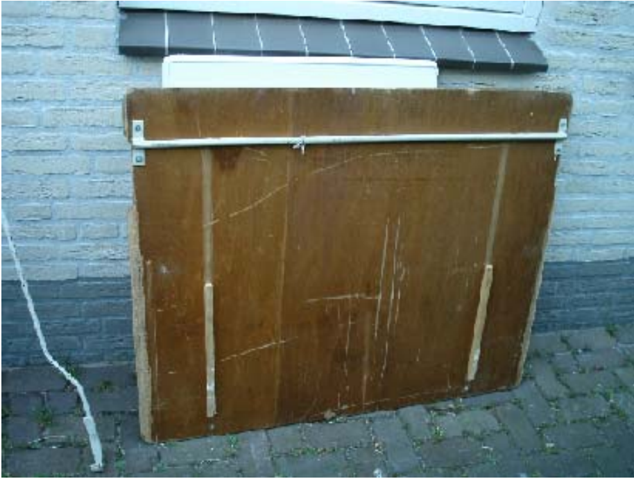
Plank met aan de onderzijde waar beugels in worden geschoven
